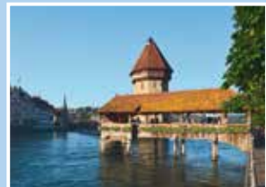
Kappelbrücke, Kanton Luzern
